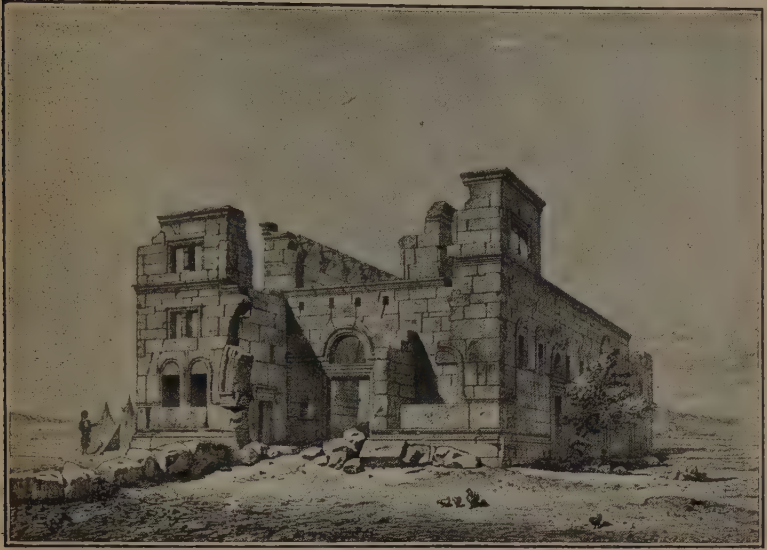
Fig. 2. — Église de Qalb-Louzé (d'après Vogüé, Syrie centrale ).
